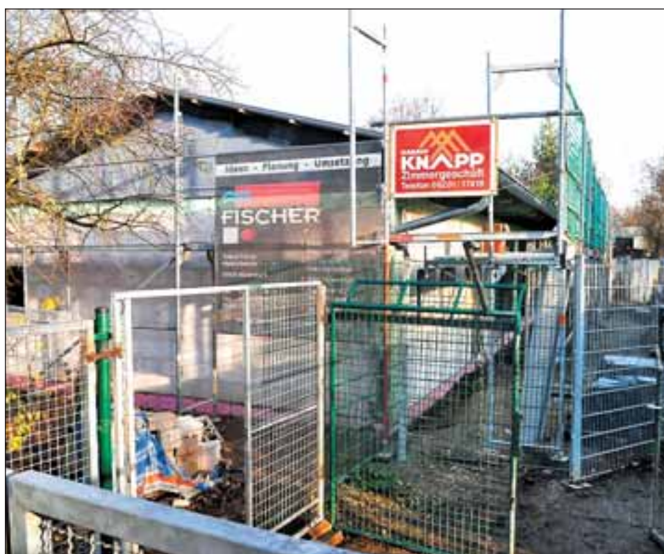
Im Frühjahr soll der Innenausbau des Hundehauses beginnen. Foto: Dorn
